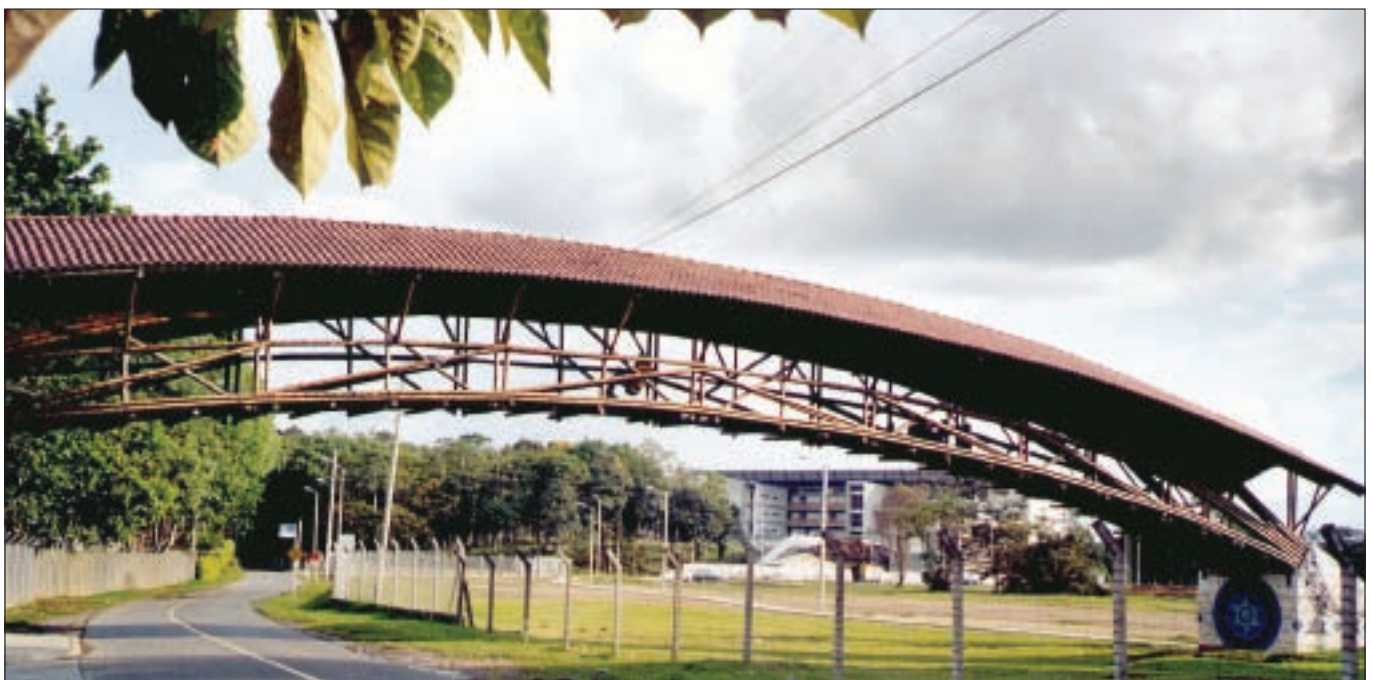
Abb. 6: Bambusbrücke in Pereira. Architekt: Jörg Stamm.
