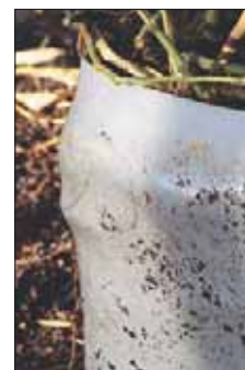
Deformationen der TPO-Bahn 1,8mm (Januar 2006).
